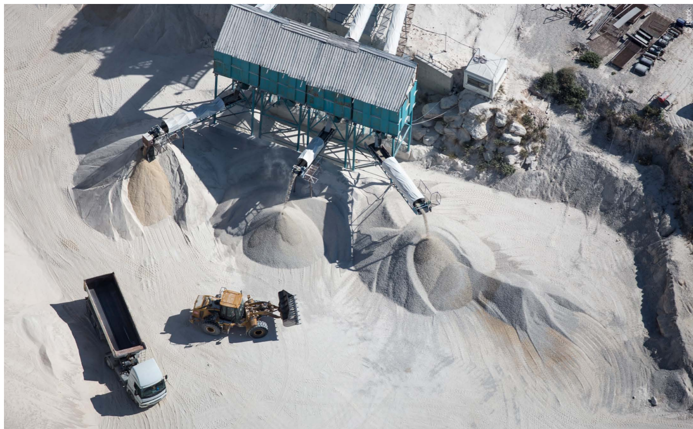
Usine de béton et ciment.
