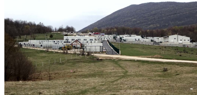
Le Temporary Reception Center de Lipa, sorti de terre en pleine montagne à 23 kilomètres de Bihać.
